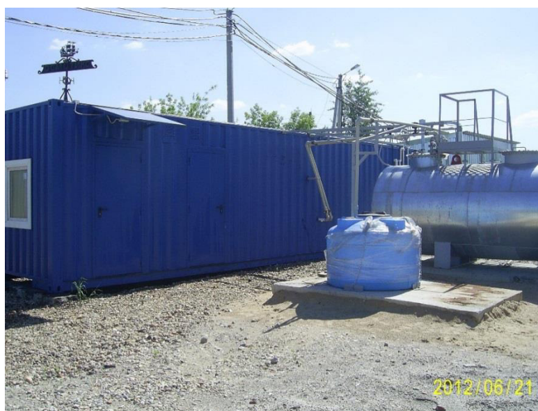
Вариант архитектурного исполнения станции очистки типа СОС
